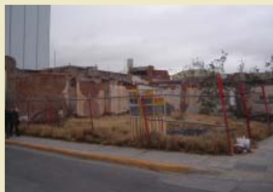
Vivienda antigua deteriorada y baldío, Centro Histórico de la ciudad de Chihuahua.
