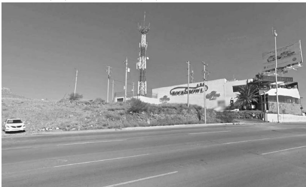
Vista del predio en estudio y las líneas de transmisión eléctrica.
