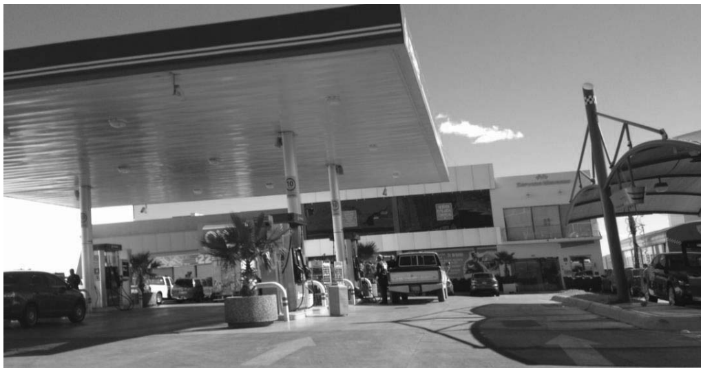
Vista de la gasolinera Misiones y del auto lavado sobre el Perif. de la Juventud Luis Donaldo Colosio Murrieta.
