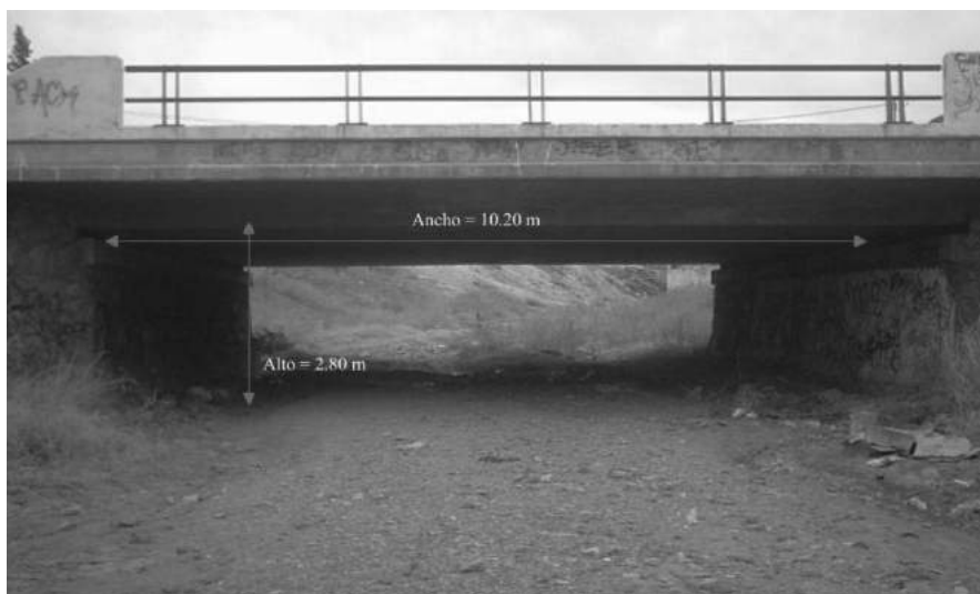
IMAGEN DE ESTRUCTURA UBICADA EN CALLE MELCHOR GUASPE
