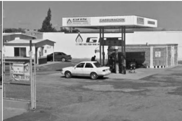
GASERA ubicado sobre la calle Melchor Guaspe
