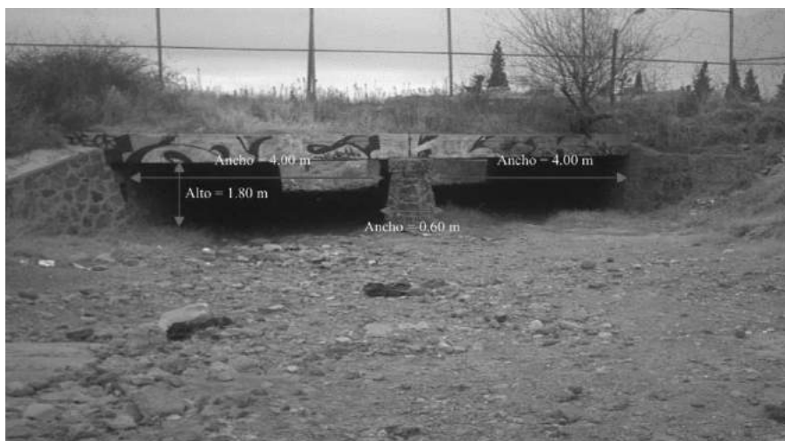
IMAGEN DE ESTRUCTURA UBICADA EN CRUCE CON PERIFÉRICO R. ALMADA
