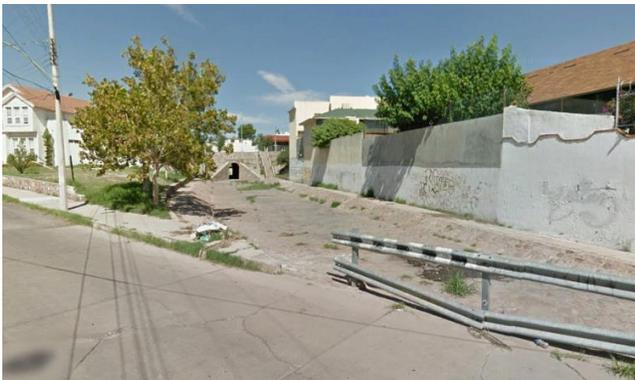
Fig. 47 Canalización de protección de escurrimientos pluviales al poniente del Área de Estudio conduciendo el Arroyo Plaza de Toros desembocando por la Calle Canal constituido por la C. Presa Falcón.<sup>57</sup>
