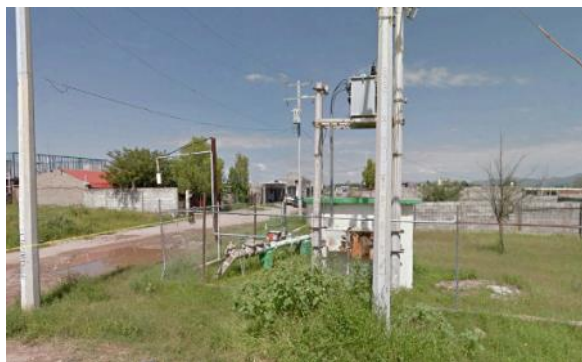
Ilustración 59. Vista del Pozo no. 9.
