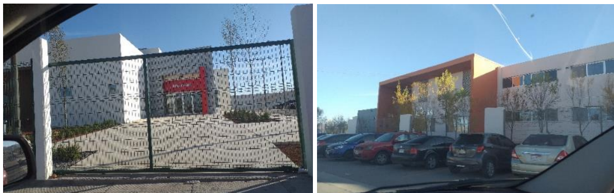
Ilustración 24. Centro de Salud Riberas y Colegio particular Riberas. Fuente: Capturas propias en campo, diciembre 2021.
