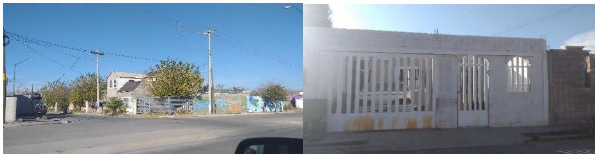
Ilustración 34. Tipologías de viviendas en colonia Riberas del Sacramento. Fuente: Captura propia en campo, diciembre 2021.
