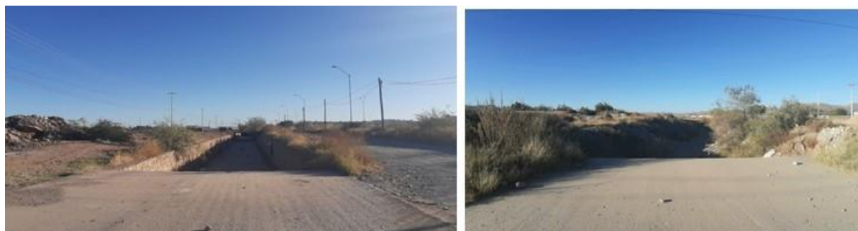
Ilustración 20. Arroyo El Álamo canalizado en un tramo dentro del predio y el arroyo con cauce natural.
