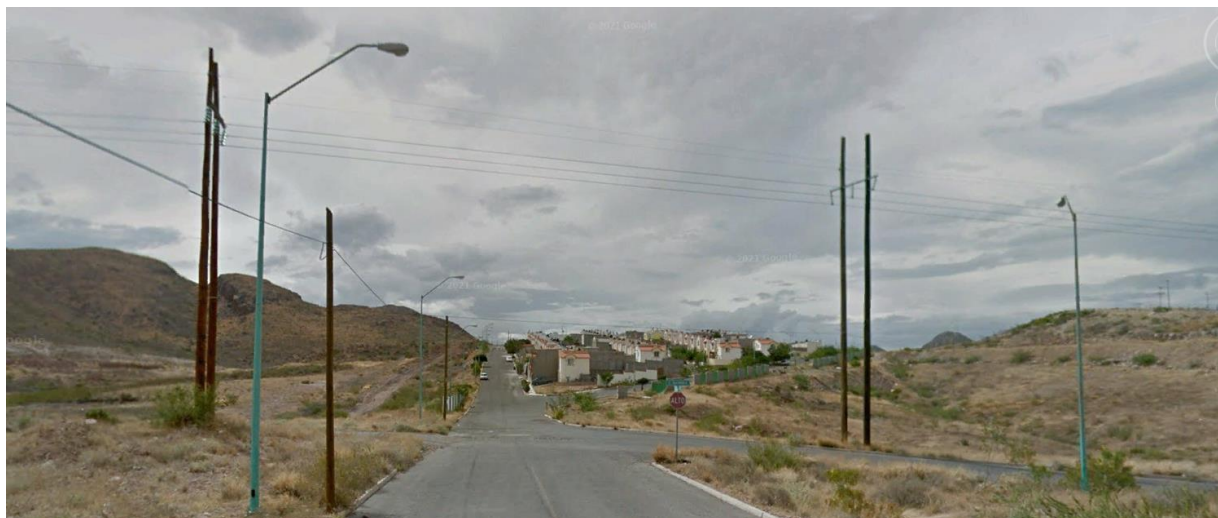
Imagen 55. Línea Eléctrica 115 Kva.
