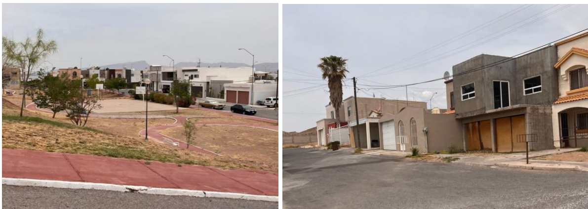
Imagen 32. Viviendas de la colonia Praderas del León y Colinas del León II. Fuente: Captura propia en campo, mayo 2022.
