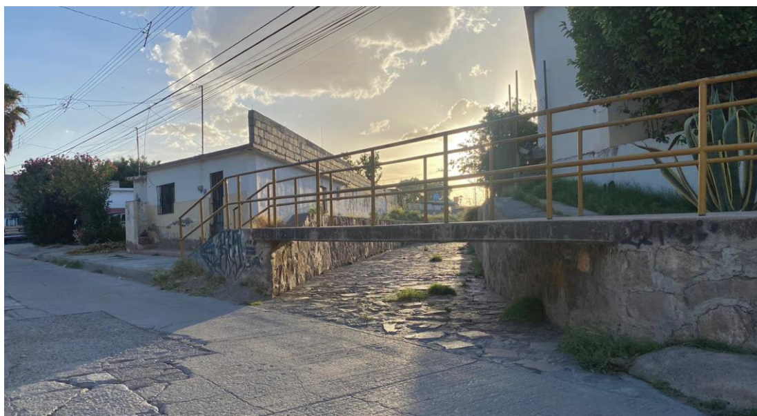
Imagen 35. Incorporación del agua pluvial de la zona al afluente del arroyo San Jorge, puntos de riesgo entre la calle Tercera e Independencia.
