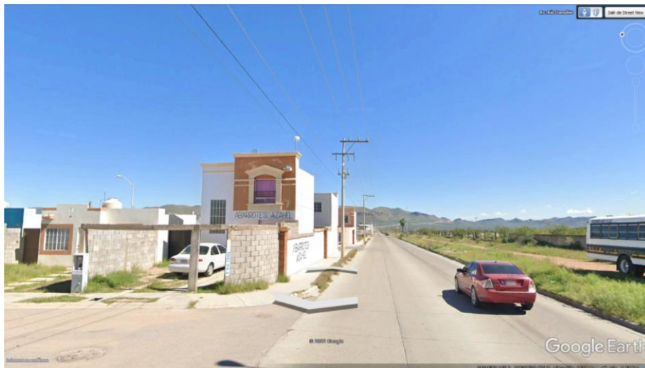
Casa habitación conteniendo giro comercial / Abarrotes en la avenida Río Danubio y calle Río Odiel Fuente: 2022 Google Earth.
