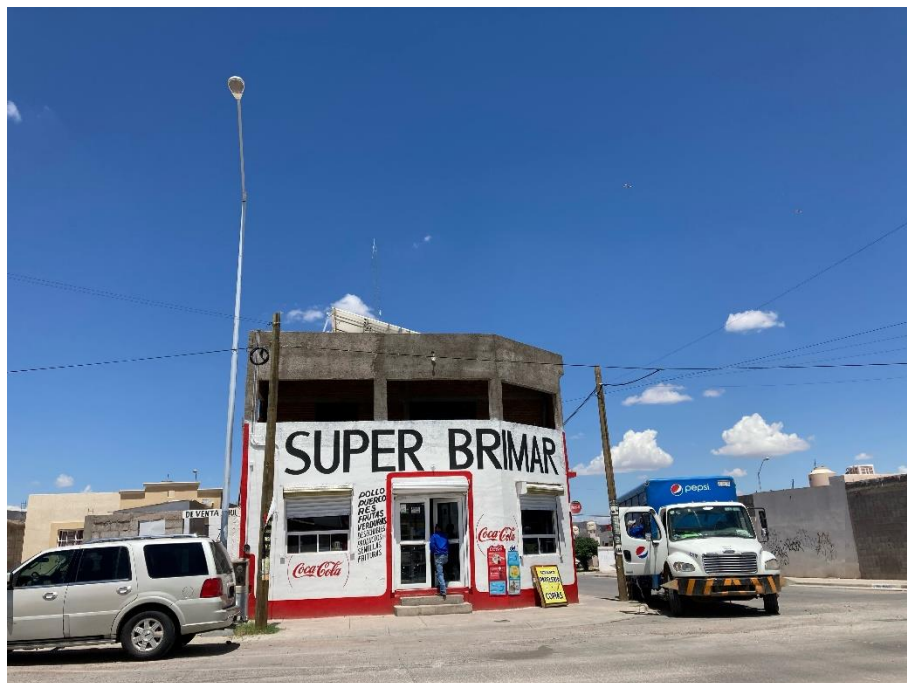
Predio en estudio y su edificación actual /Mini Super Brimar Fuente propia
