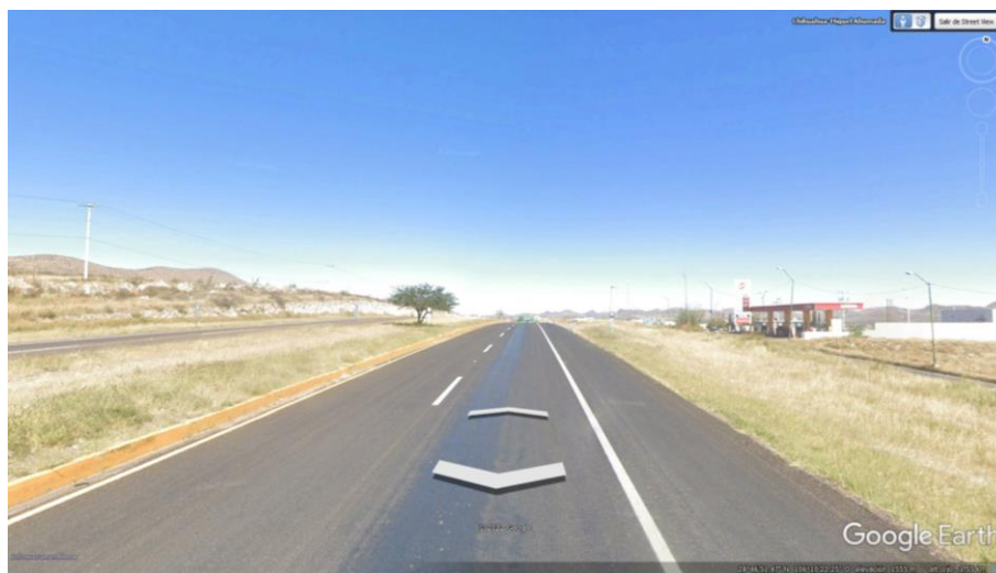
Avenida Cristóbal Colón Fontanarrosa / Autopista Miguel Ahumada - Chihuahua
