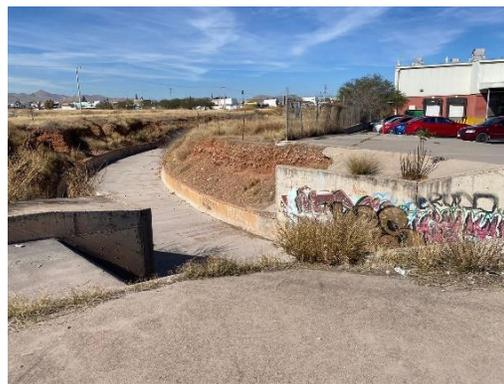
*Imagen 18. Revestimiento y cauce natural Arroyo Los Arcos, tramo entre Av. Paseos del Real y Av. Hidroeléctrica Chicoacén*
