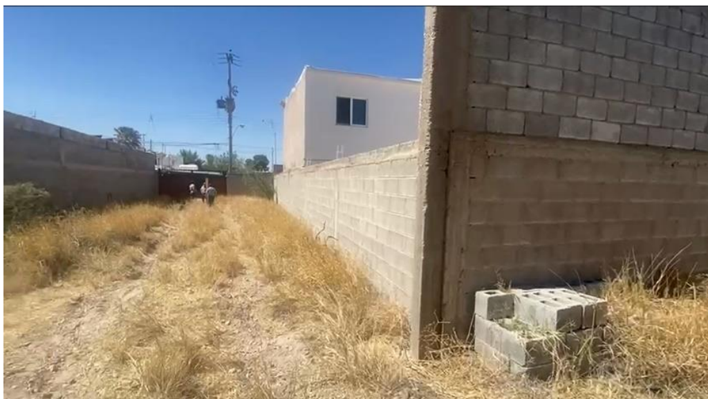
Vista desde el interior, desde su fondo hacia el acceso y colindancia derecha Fuente: Propia
