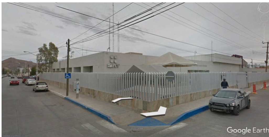
Tipología de locales de comercio y servicios. Oficinas del SAT Ubicado en la esquina de las calles Pino y Cosmos Fuente: 2022 Google Earth Pro
