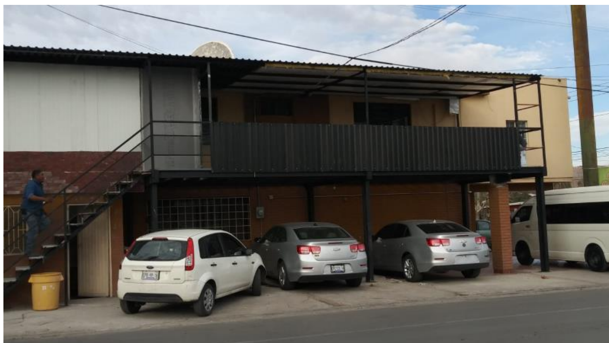
Imagen 49. Fachada del predio. Mayo 2022.
