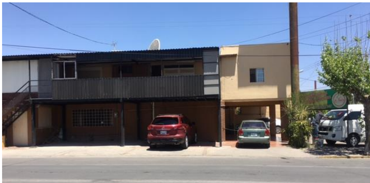
Imagen 48. Fachada del predio. Mayo 2022.
