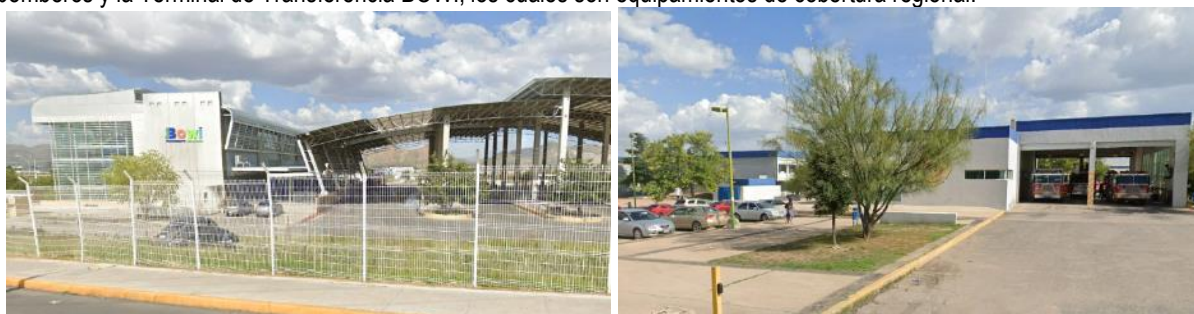
Imagen 54. Estación de Transferencia Bowi y Estación Dual de Bomberos y Policía. Fuente: Google Earth, Captura julio 2022.
