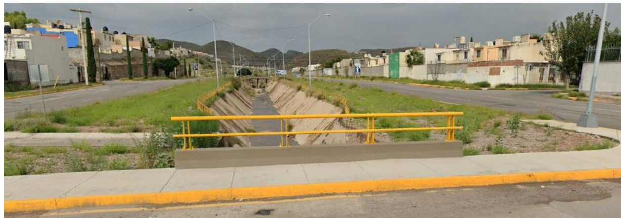
Imagen 34. Arroyo El Mimbres Sur vista desde la Av. Homero.
