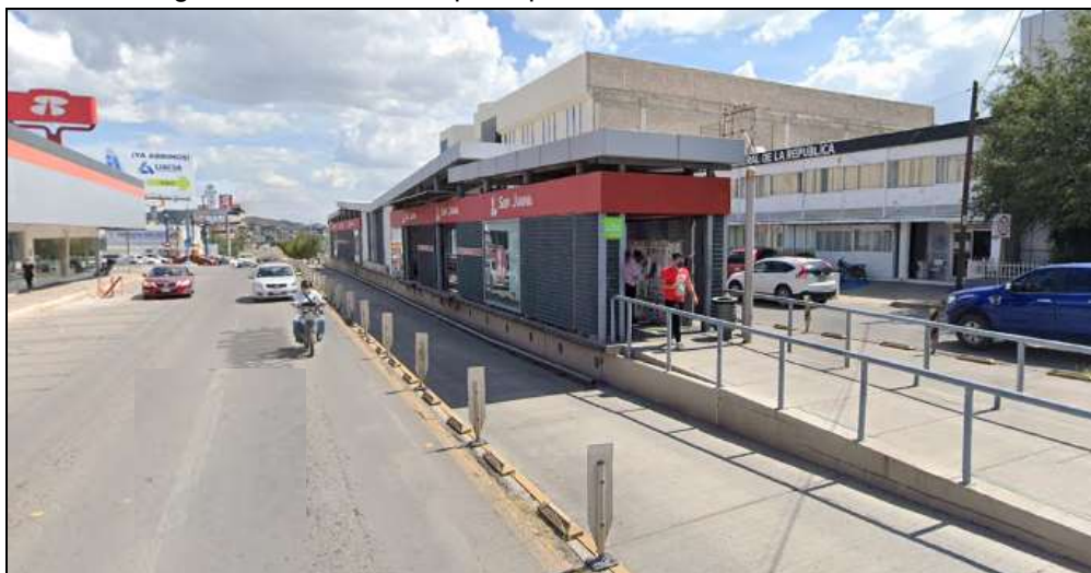
Imagen 38. Ruta de transporte público sobre la la av. Universidad.
