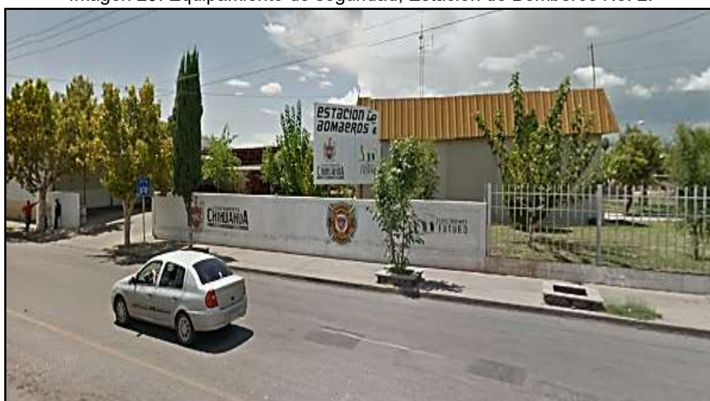
Imagen 29. Equipamiento de seguridad, Estación de Bomberos No. 2.
