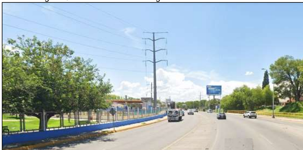
Imagen 43. Infraestructura de energía eléctrica en av. De la cantera.
