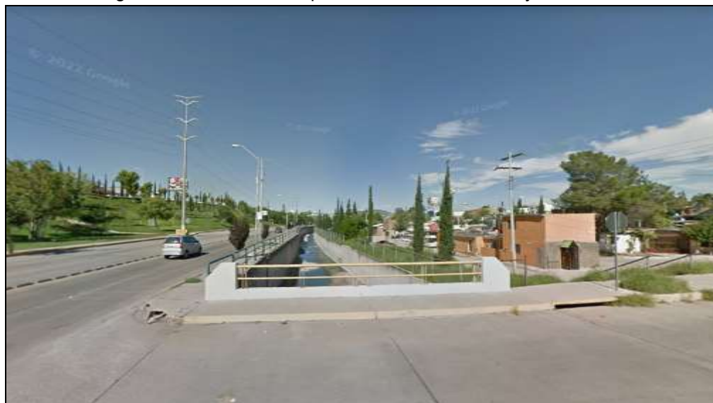
Imagen 50. Infraestructura pluvial, canalización. Arroyo la Cantera.
