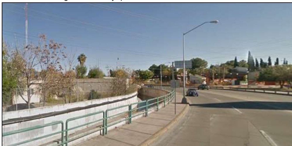
Imagen 9. Desalojo pluvial sobre avenida De la Cantera.
