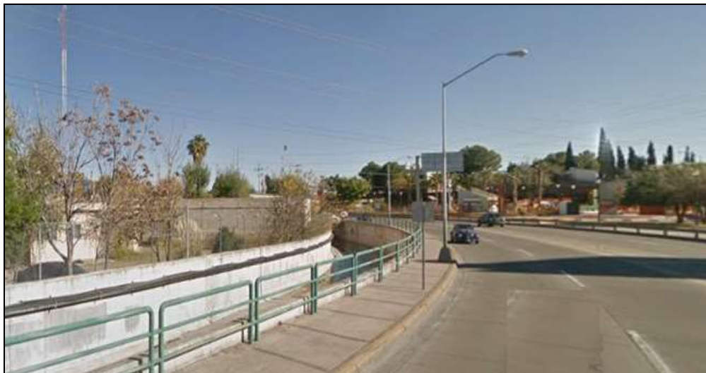
Imagen 46. Desalojo pluvial sobre avenida De la Cantera.
