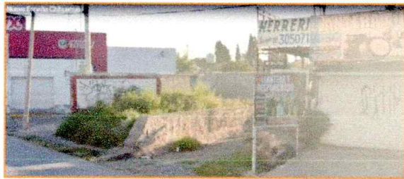
Imagen 20. Infraestructura pluvial existente de paso a desnivel vehicular Arroyo San Jorge. Fuente. Fotografía Propia.
