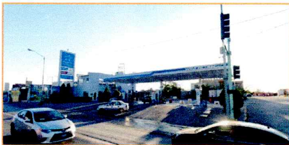
Imagen 10. Comercio y Servicio. Gasolinera. Fotografía Propia.
