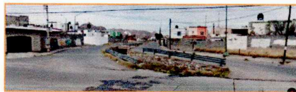
Imagen 2. Cruce de Arroyo San Jorge, entre Boulevard José Fuentes Mares y Calle Novena. Fotografía Propia.
