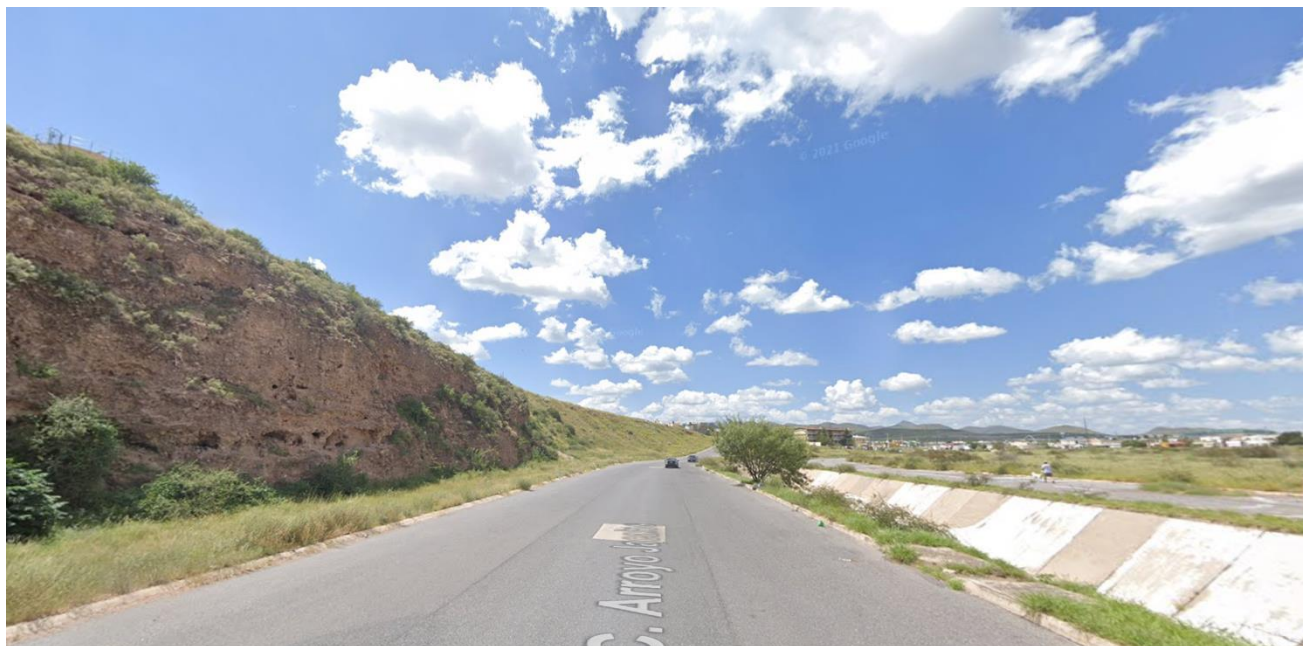
Ilustración 44. Arroyo Los Nogales en el norte del predio.
