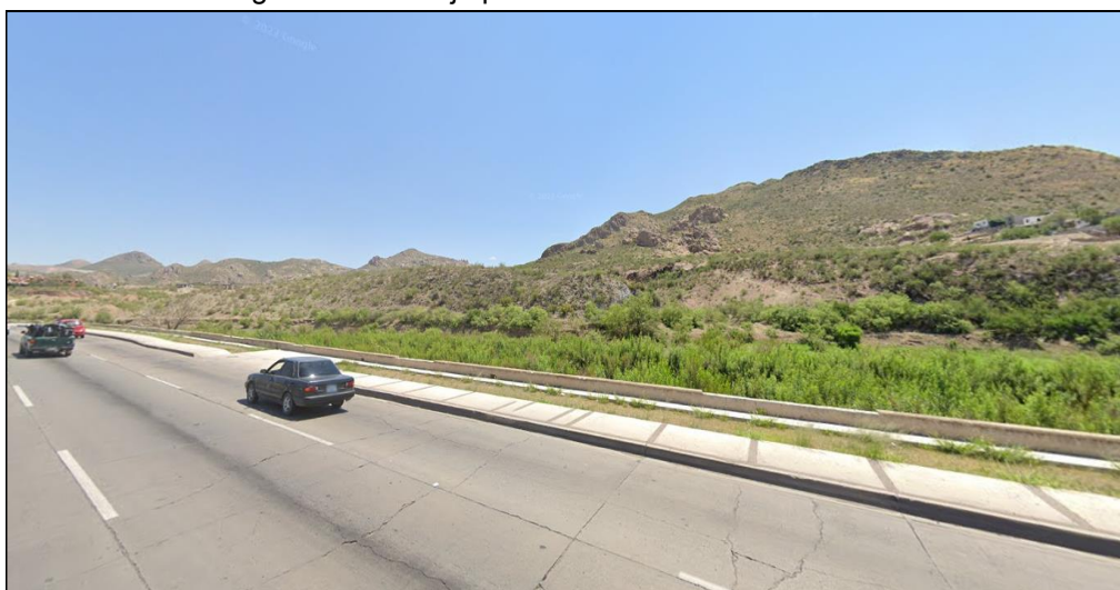
Imagen 26. Desalojo pluvial sobre Vialidad Sacramento.
