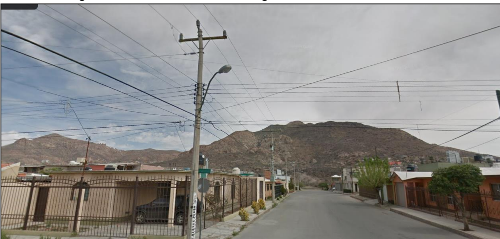
Imagen 68. Infraestructura de energía eléctrica en calle Río Bravo.
