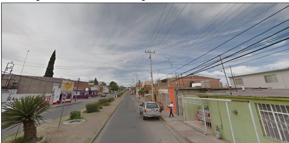
Imagen 66. Infraestructura de energía eléctrica en calle Río Sacramento
