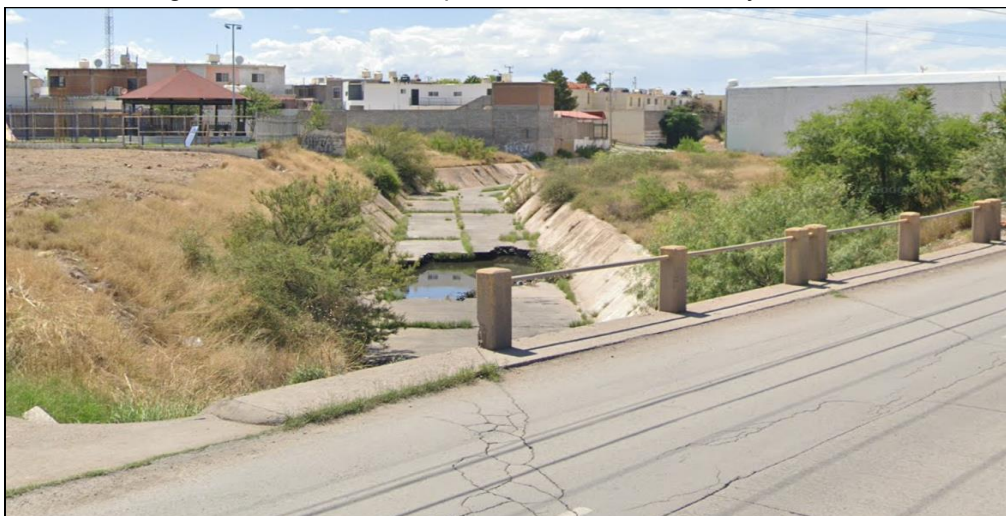
Imagen 71. Infraestructura pluvial, canalización. Arroyo la Galera.
