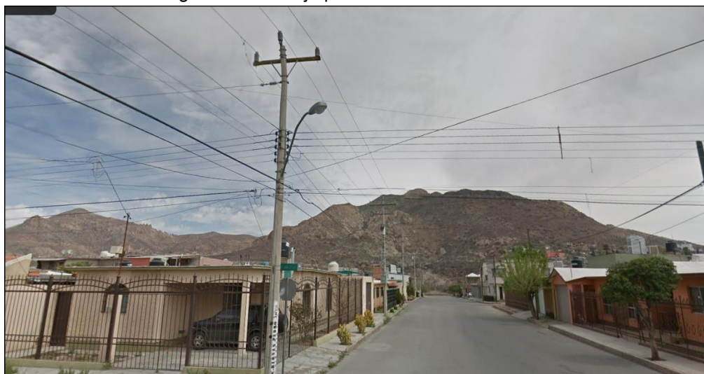
Imagen 64. Desalojo pluvial sobre calle Río Bravo.
