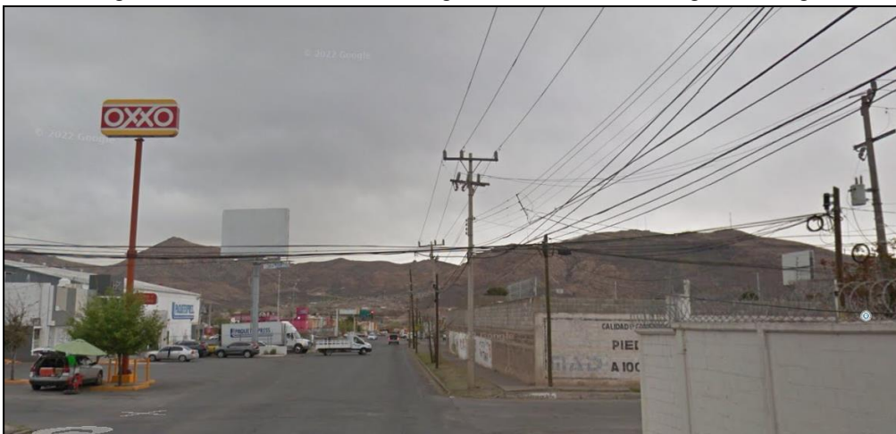
Imagen 67. Infraestructura de energía eléctrica en la av. Agustín Melgar
