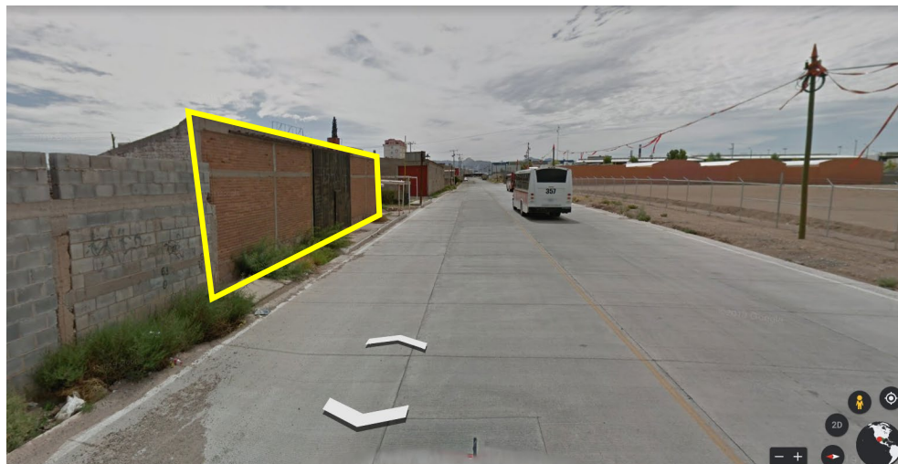
Frente del predio en estudio. Vista desde la calle Industrial 2 hacia el oriente. Fuente Google Earth. Fecha de las imágenes: 22/4/23
