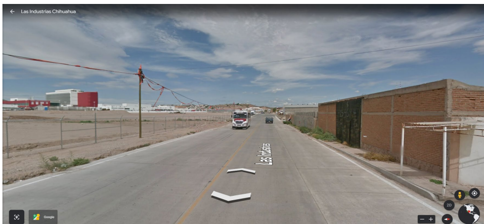
Calle Industrial 2 y el predio en estudio ubicada al lado derecho de la imagen Fuente: Google Earth 2023
