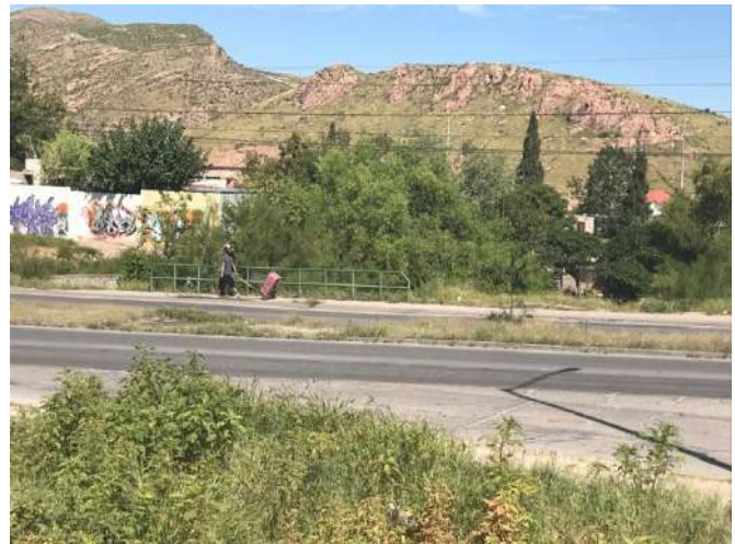
Fig. 58 Cauce de arroyo San Rafael. 68
