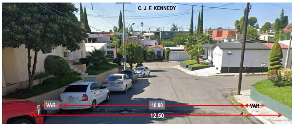
Imagen 74. Sección vial actual e imagen de la C. J. F. Kennedy. Fuente PDU 2040.
