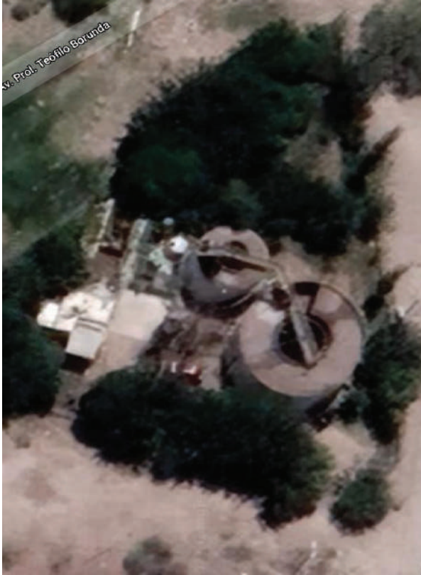
Figura 199. Planta de tratamiento Boreal Planta construida para el tratamiento de aguas servidas de la empresa Brasa para el fraccionamiento denominado Boreal, ubicado al occidente de la reserva Labor de Dolores.
