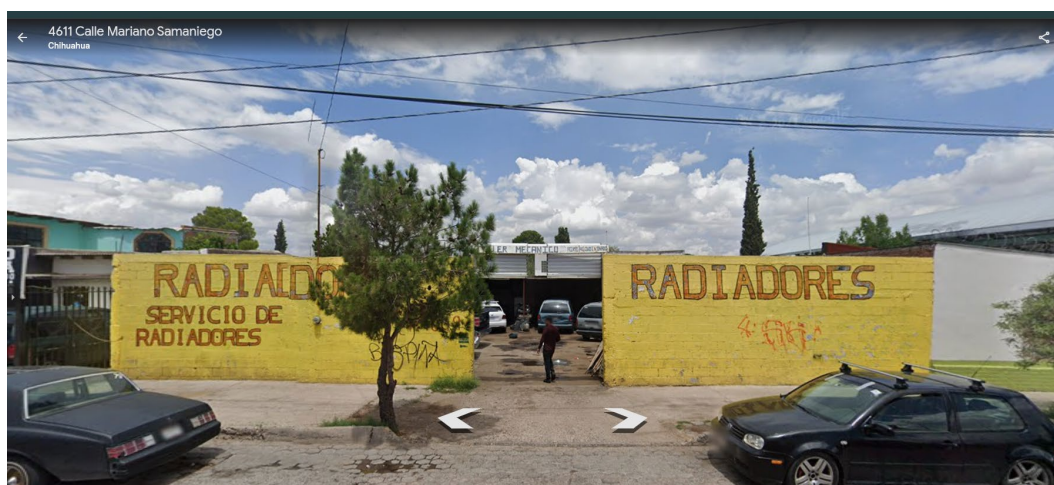
Taller de servicio de Radiadores, ubicada en la calle José Mariano Samaniego Delgado, frente al predio en estudio.
