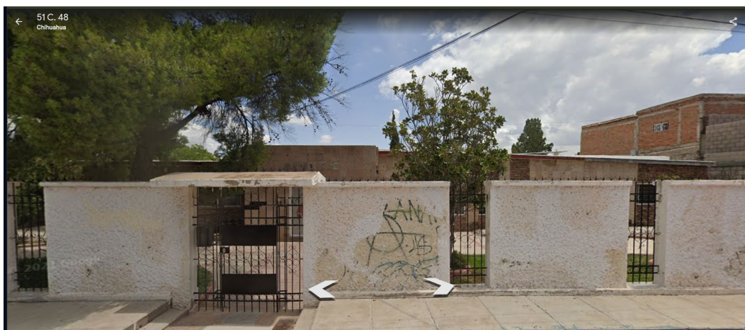
Casa Hogar para Ancianos Amor y Fe, ubicada en la calle 48ª. Fuente: 2024 Google Earth Pro Image ©2024 Maxar Technologies
