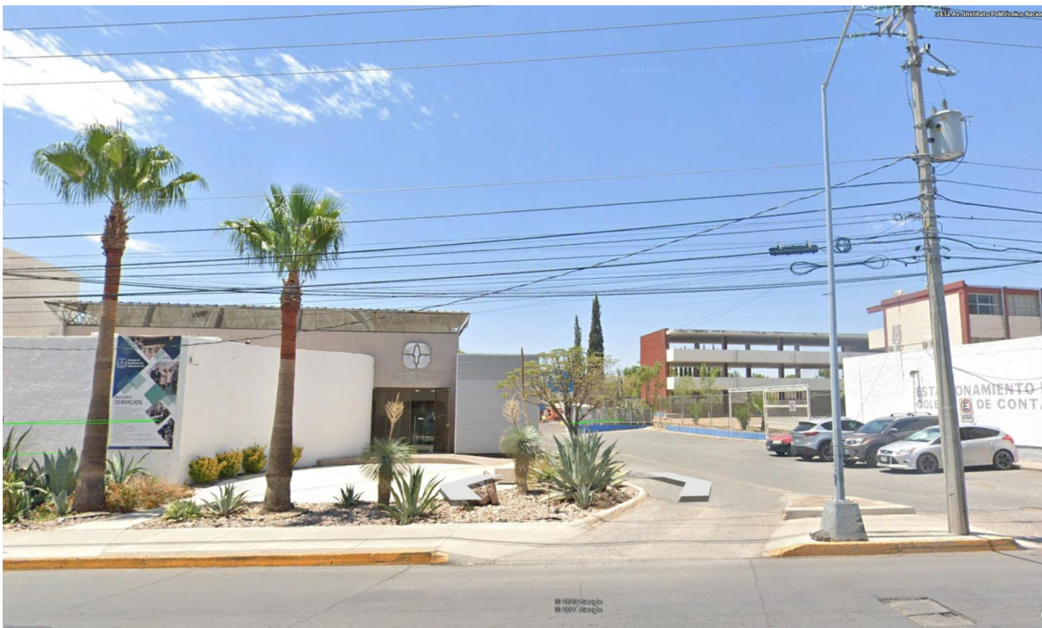
Colegios de Contadores, Arquitectos y CUDACH
