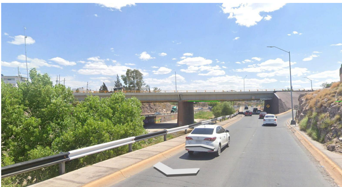
Vista hacia el poniente del río Chuvíscar en su intersección con la Av. Politécnico Nacional y/o Presa de Tecomatlán. Fuente: Google Earth Pro. Fecha de imágenes agosto 2021.
