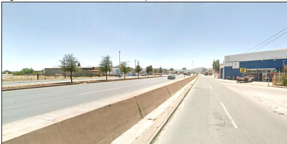
Imagen 10. Canalización de escurrimientos pluviales sobre el Blvd José Fuentes Mares.
