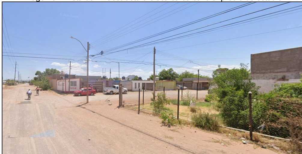
Imagen 61. Vista de infraestructura eléctrica cercana al predio de estudio.
