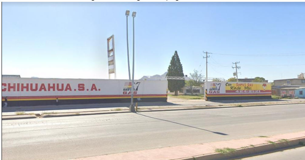
Imagen 57. Riesgo antropogénico, Gasera.
