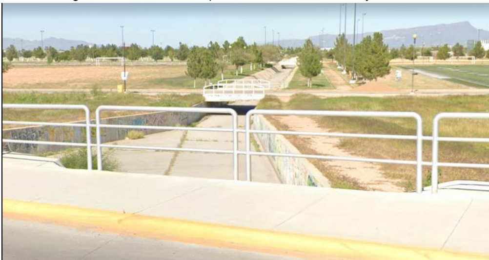
Imagen 53. Escurrimientos pluviales con rumbo al arroyo Concordia.
