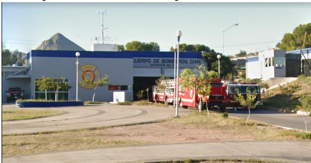
Imagen 58. Unidad de atención de emergencia, Estación de Bomberos.
