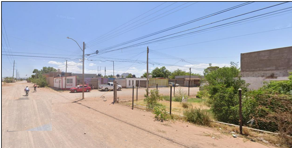
Imagen 52. Vista de redes eléctricas frente al predio de estudio.
