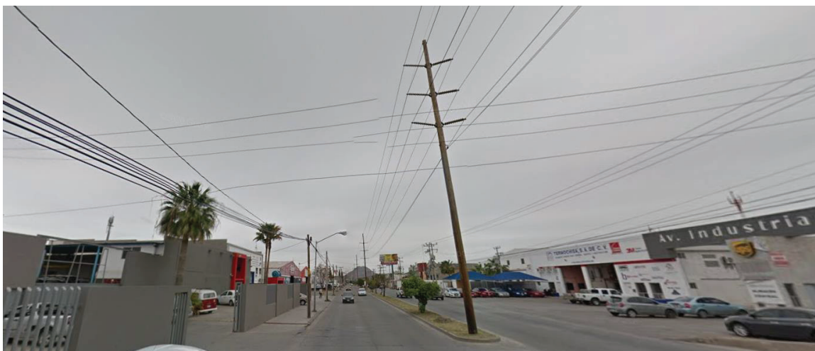
Imagen 30. Sección Vial actual Av. De las Industrias. Fuente: propia TDU, julio 2024
