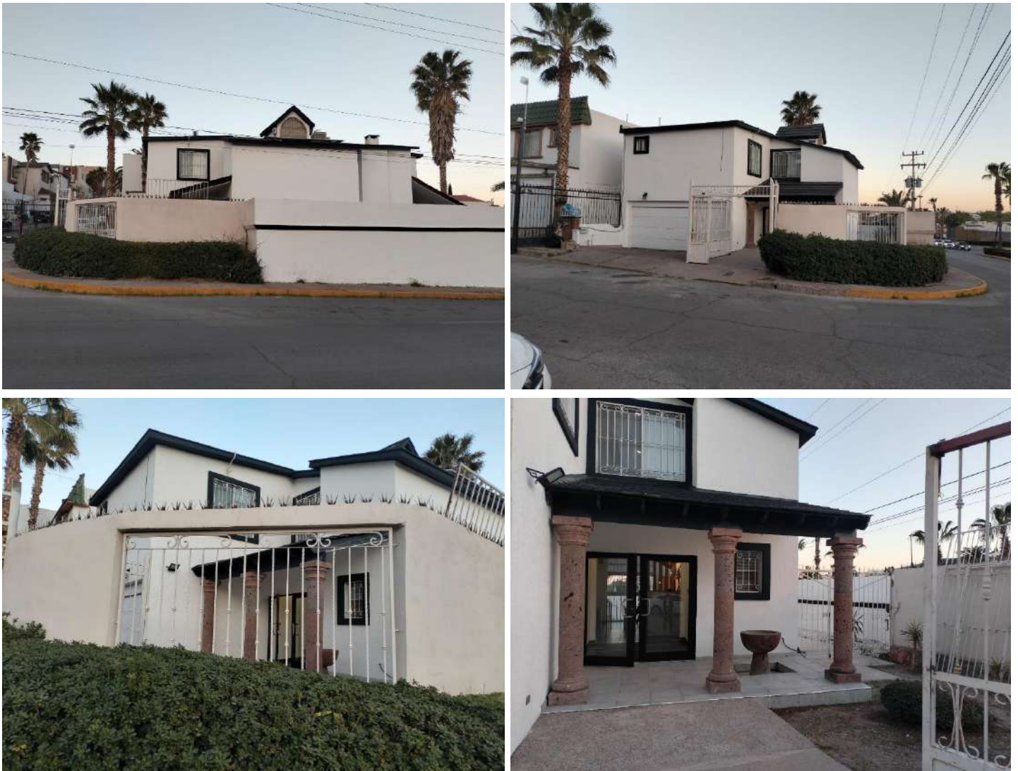
Figura 3.- Vistas actuales del predio desde la Calle Ocotillos.
