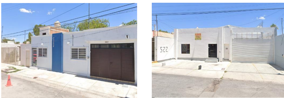
Figura 78 – Oficina y Centro de Salud y Bienestar. Fuente: Propia.
