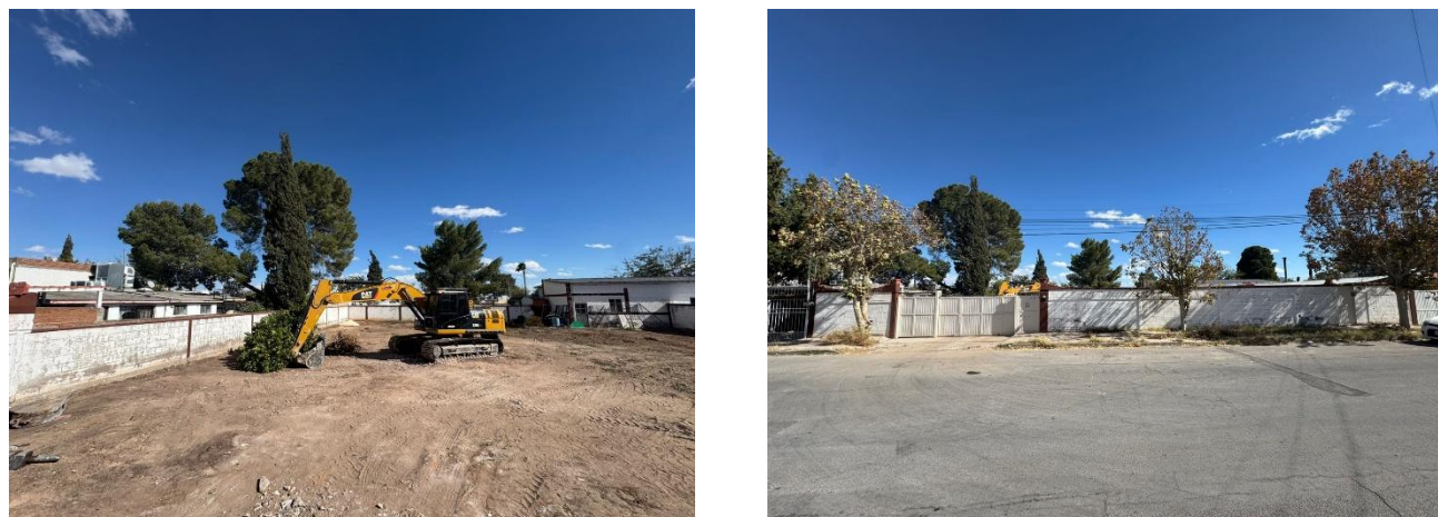
Figura 13 – Vistas interior y exterior del predio en Proceso de Demolición. Fuente: Propia.
