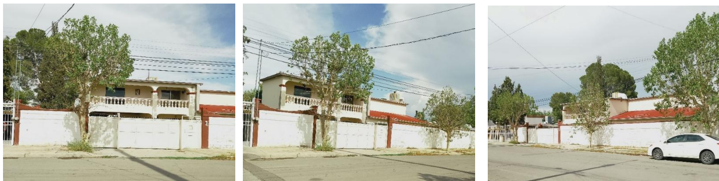
Figura 12- Vistas frontales y lateral del predio en estudio antes de su Demolición. Fuente: Propia.
