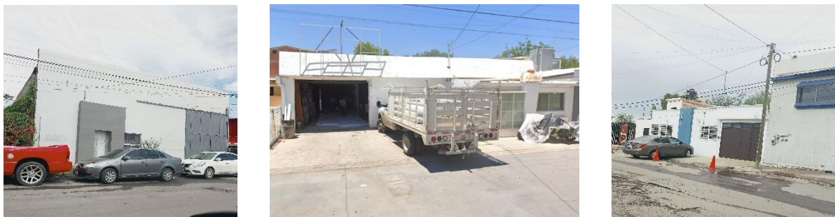
Figura 77 – Oficinas (Izquierda), Bodega (En medio) y Oficina (Derecha). Fuente: Propia.
