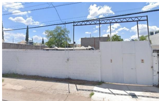
Figura 71 – Predio con uso para Resguardo de Vehículos. Fuente: Propia.
