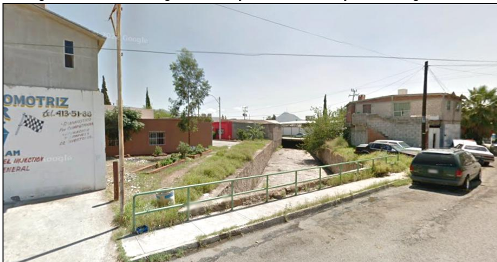
Imagen 60. Punto de riesgo en el arroyo La Galera sur, y la calle Miguel Schulls.
