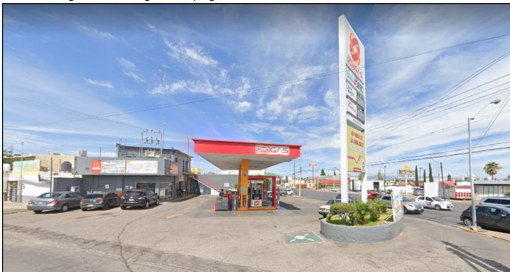
Imagen 62. Riesgo antropogénico, Gasolinera, en Av. De las Américas.
