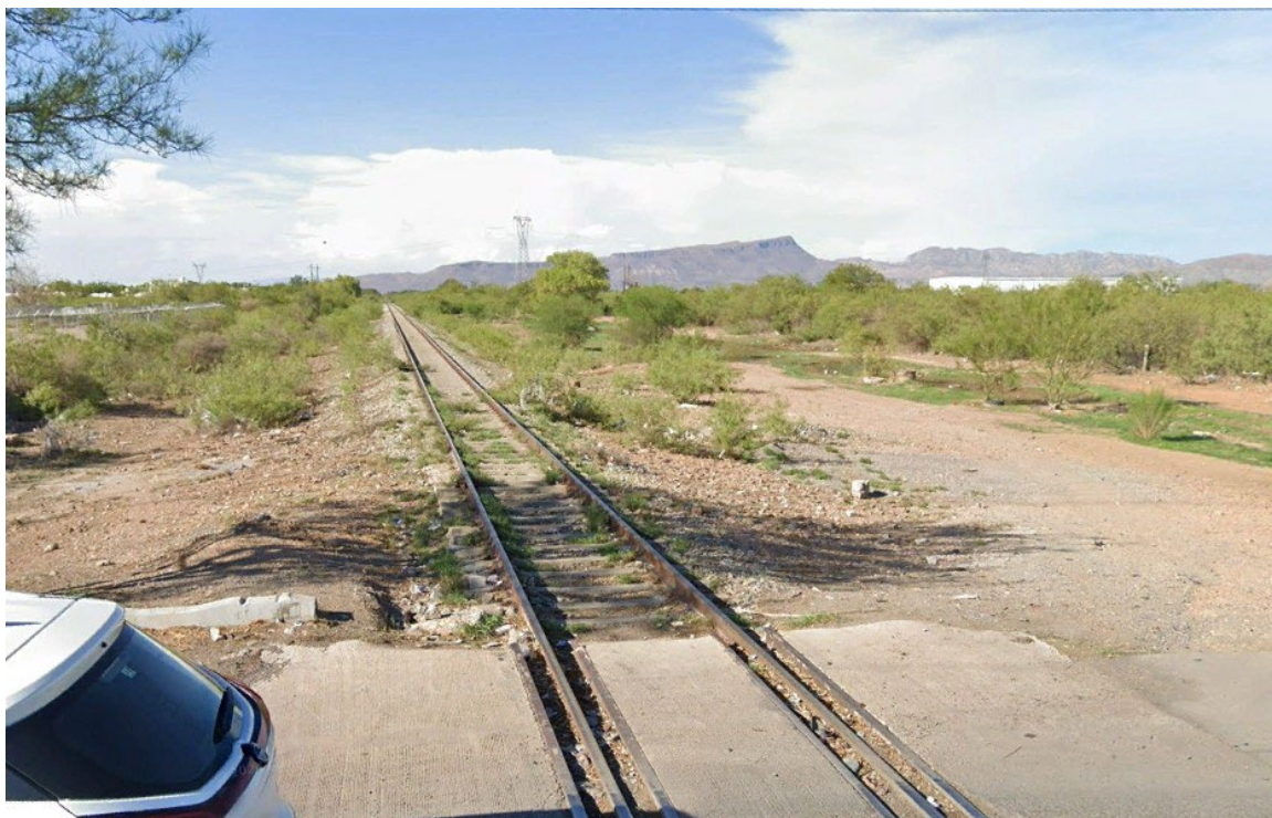
IMAGEN 66.- Vías del FFCC. Fuente: Elaboración propia.
