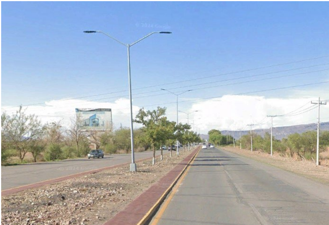
IMAGEN 76.- Luminarias en la Av. Fuerza Aérea Mexicana. Fuente: Elaboración propia.
