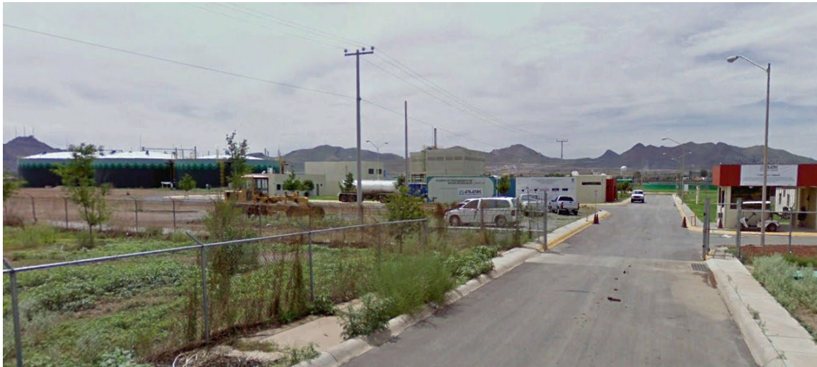
IMAGEN 88.- Planta de Tratamiento de Aguas Residuales Sur. Fuente: Elaboración propia.
