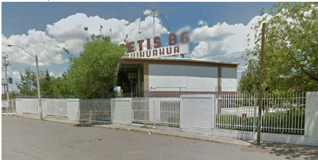
IMAGEN 49.- Instalaciones CETIS 86. Fuente: Elaboración propia.
